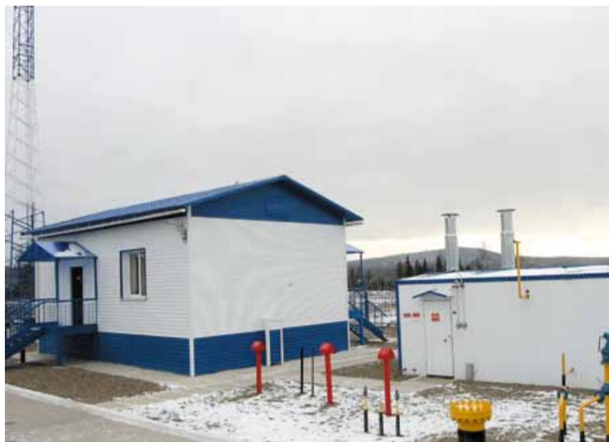
С этой газораспределительной станции газ подается потребителям Братска
