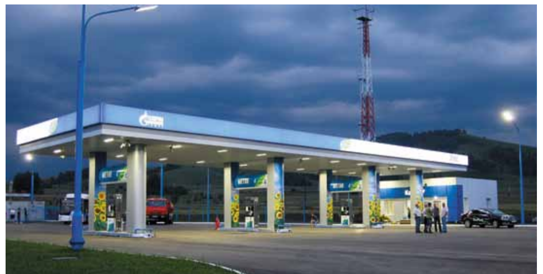
АГНКС в Республике Алтай, на которой установлено оборудование компании BAUER Compressors
